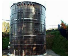
貯湯槽（保温前）
